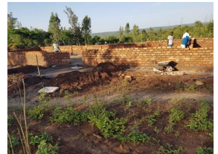
Start bouw Kosele gezondheidscentrum
